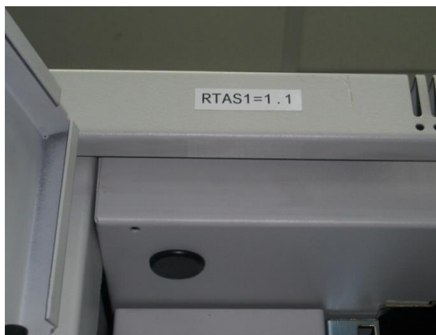
Figura 4 - Etiquetado de armario en repartidor compuesto por un único armario
