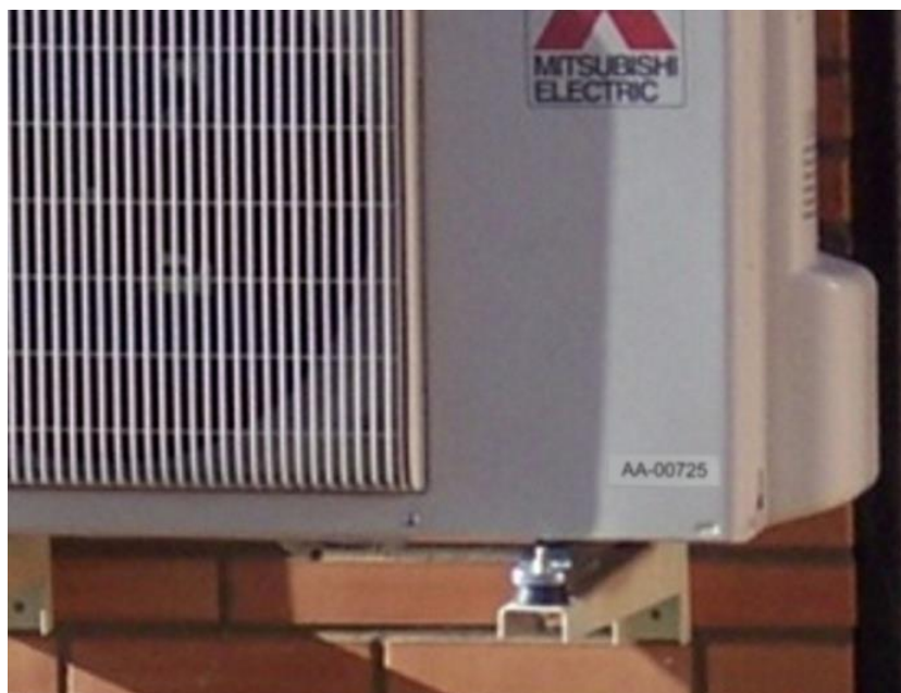
Figura 29 - Etiquetado de Unidad Exterior o Condensadora
