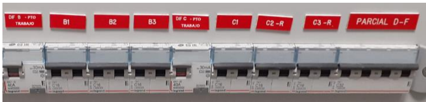
Figura 21 - Etiquetado con placas serigrafadas autoadhesivas de Protecciones en Servicio SAI
