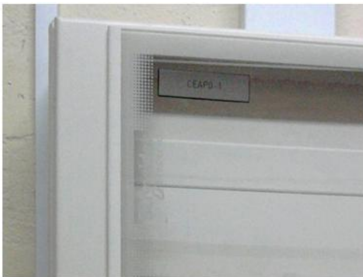
Figura 15 - Etiquetado de cuadro eléctrico sin parte fija exterior en el frontal y puerta transparente.
