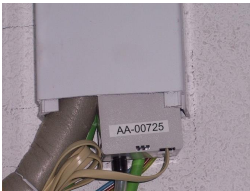
Figura 28 - Etiquetado de Bomba de Condensación
