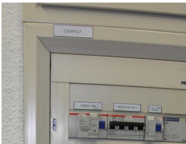
Figura 14 - Etiquetado de cuadro eléctrico con parte fija exterior en el frontal
