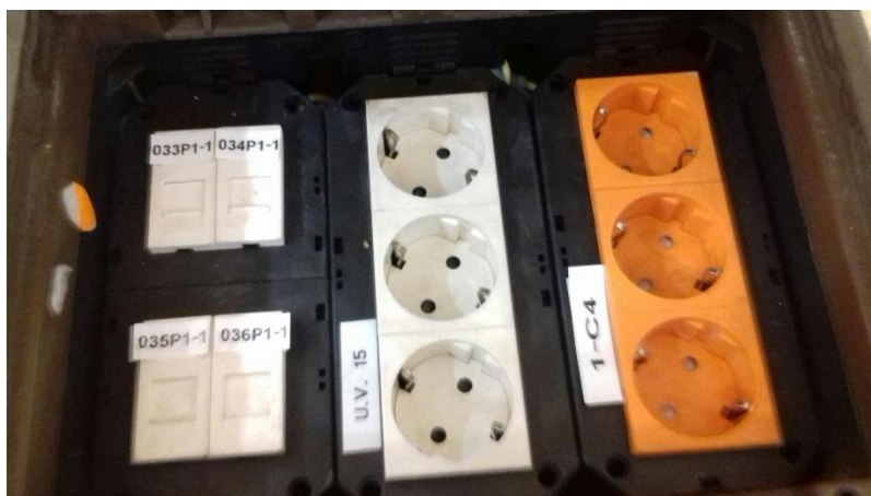
Figura 23 - Etiquetado de Tomas Eléctricas
