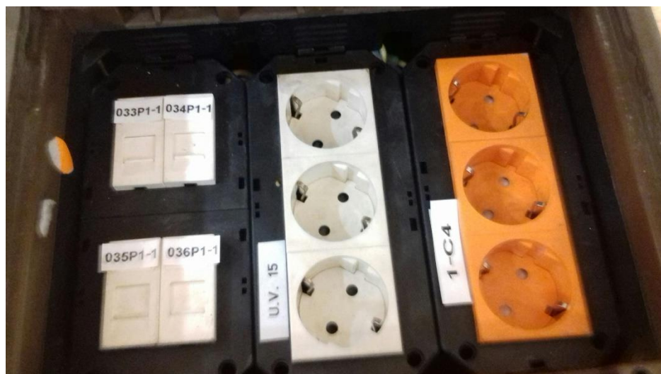
Figura 11 - Etiquetado de punto de conexión de la red multiservicio
