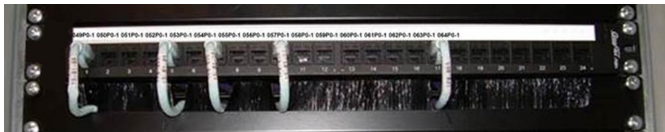
Figura 9 - Etiquetado de puertos en paneles horizontales
