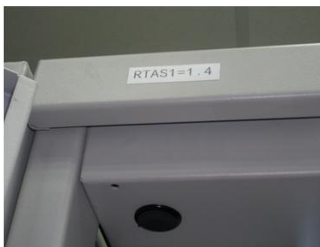
Figura 5 - Etiquetado de armario en repartidor compuesto por varios armarios
